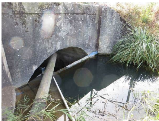
Figure 5: Batardeau à l'entrée du pont sous les CFF
