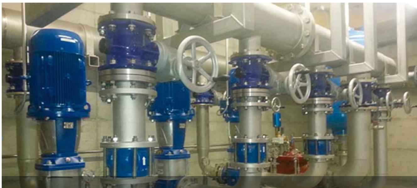
Ces nouvelles interconnexions entre les réseaux d'eau potable existants permettent non seulement d'exploiter de nouvelles potentialités de turbinage sur l'ensemble des trois communes, mais également de diminuer le recours au pompage et au traitement des eaux issues des puits de la plaine : mis en commun, l'efficacité de l'exploitation des réseaux d'eau potable des trois communes est fortement améliorée.
